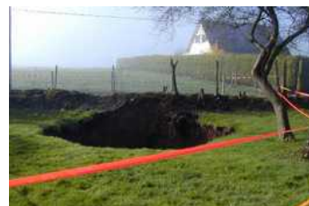
Mouvement de terrain (falaises et cavités souterraines)
