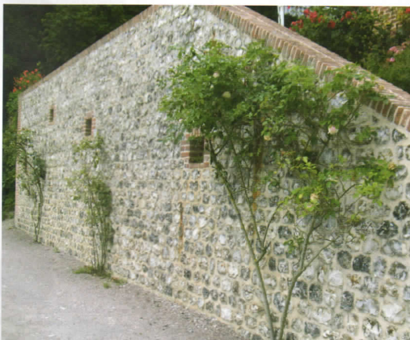
Exemple de protection avec grille métallique et entourage en briques, rectangulaire ou arrondi.
