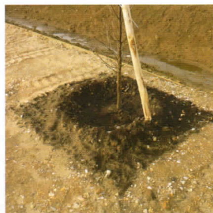
Tuteur en oblique avec cuvette d'arrosage
